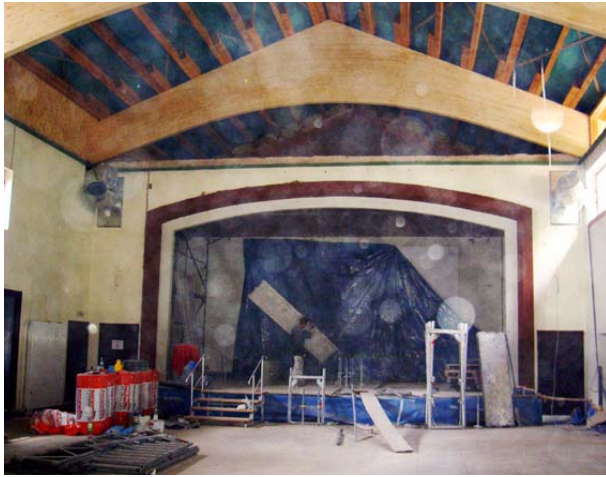
Baustelle großer Saal
